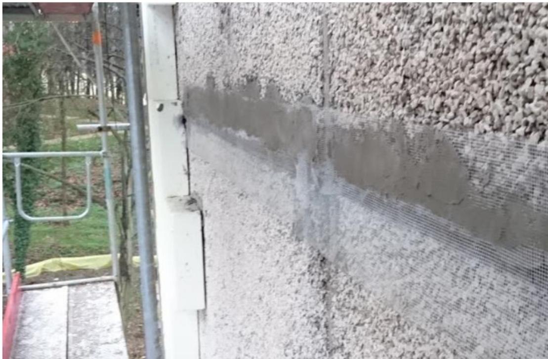
Fot 6. Sposób montażu siatki uniemożliwiającej powrót nietoperzy do schronień. (fot. M. Dworak)
