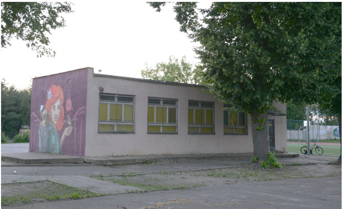
Fot 3. Budynek gospodarczy przeznaczony do rozbiórki. (fot. M. Dworak)
