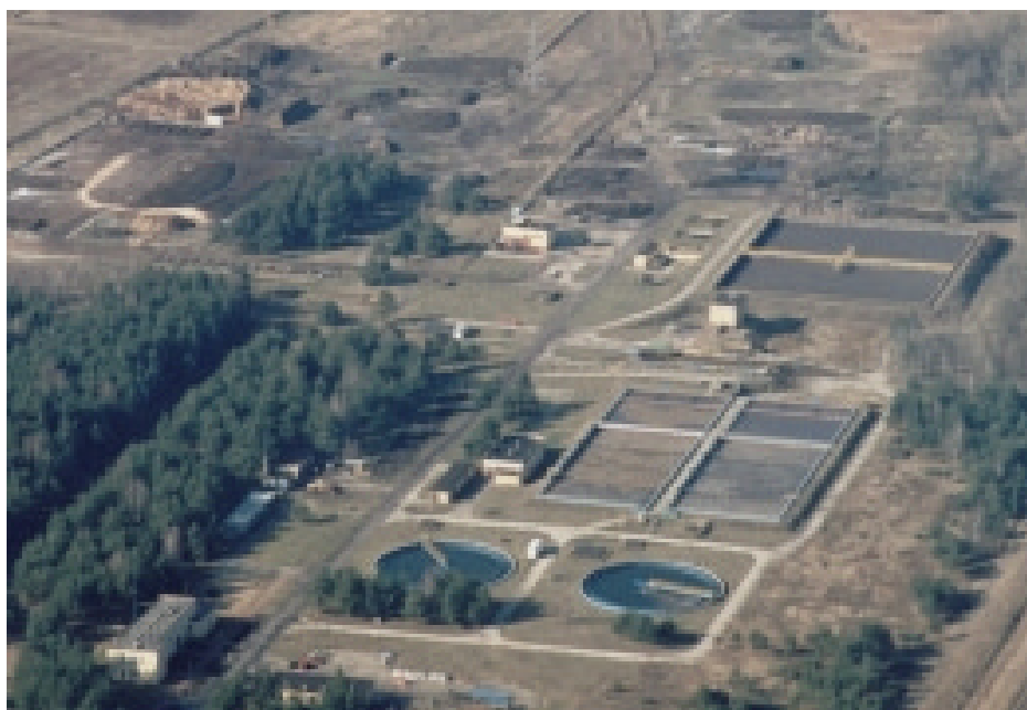
Fot. 8. Oczyszczalnia ścieków w Pile-Leszkowie.
