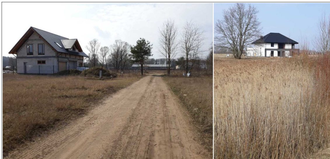
Budynki mieszkalne w budowie, w granicach wyznaczonego terenu MN4 .
