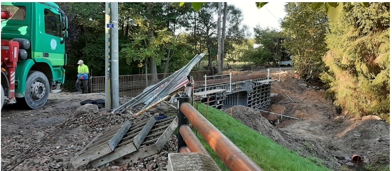
budowa nowego mostu w Kłodzie w miejscu rozebranego obiektu
