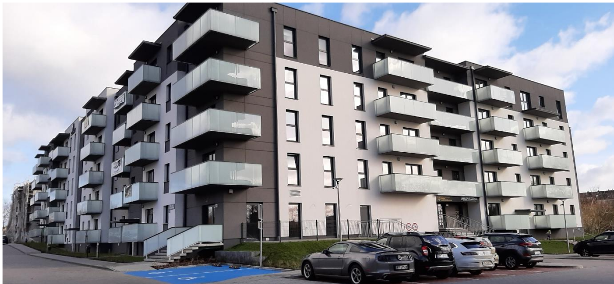
budynek mieszkalny wielorodzinny
