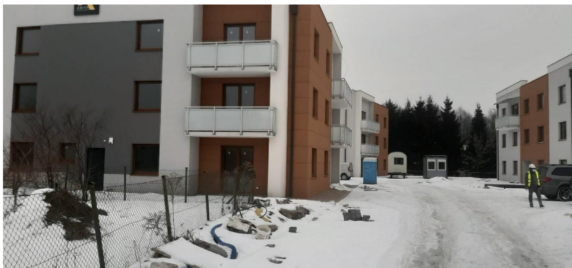
budowa budynków mieszkalnych wielorodzinnych w Pile
