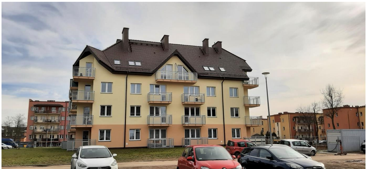
budynek mieszkalny wielorodzinny
