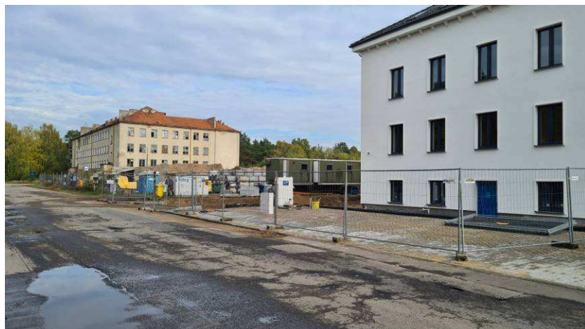
Fotografia 11 Budynki pokoszarowe w trakcie adaptacji na budownictwo wielorodzinne
