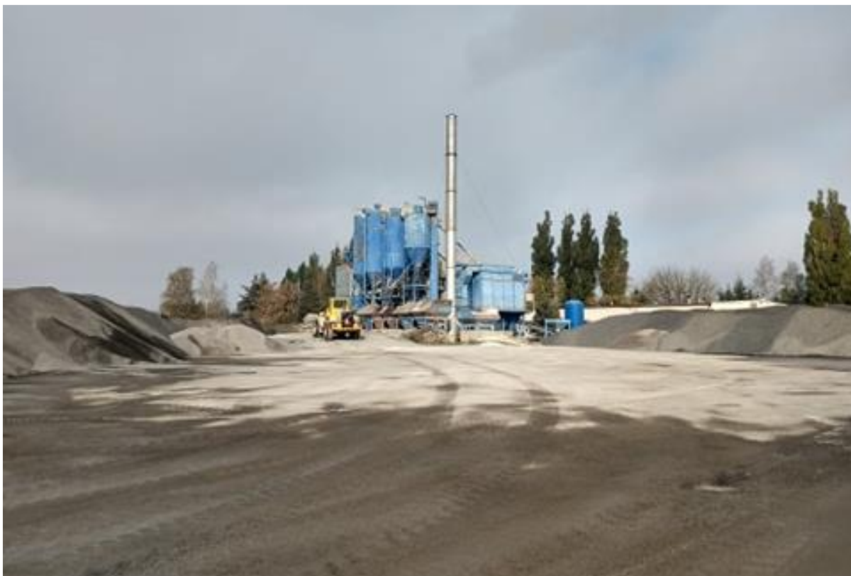
Instalacja wytwórni mas bitumicznych oraz place składowe kruszywa, widok w kierunku północno-zachodnim.
