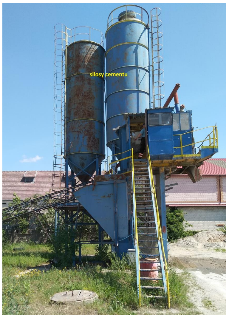
Silosy cementu stanowiące elementy wytwórni betonu ELBA typu EMC 35 B.
