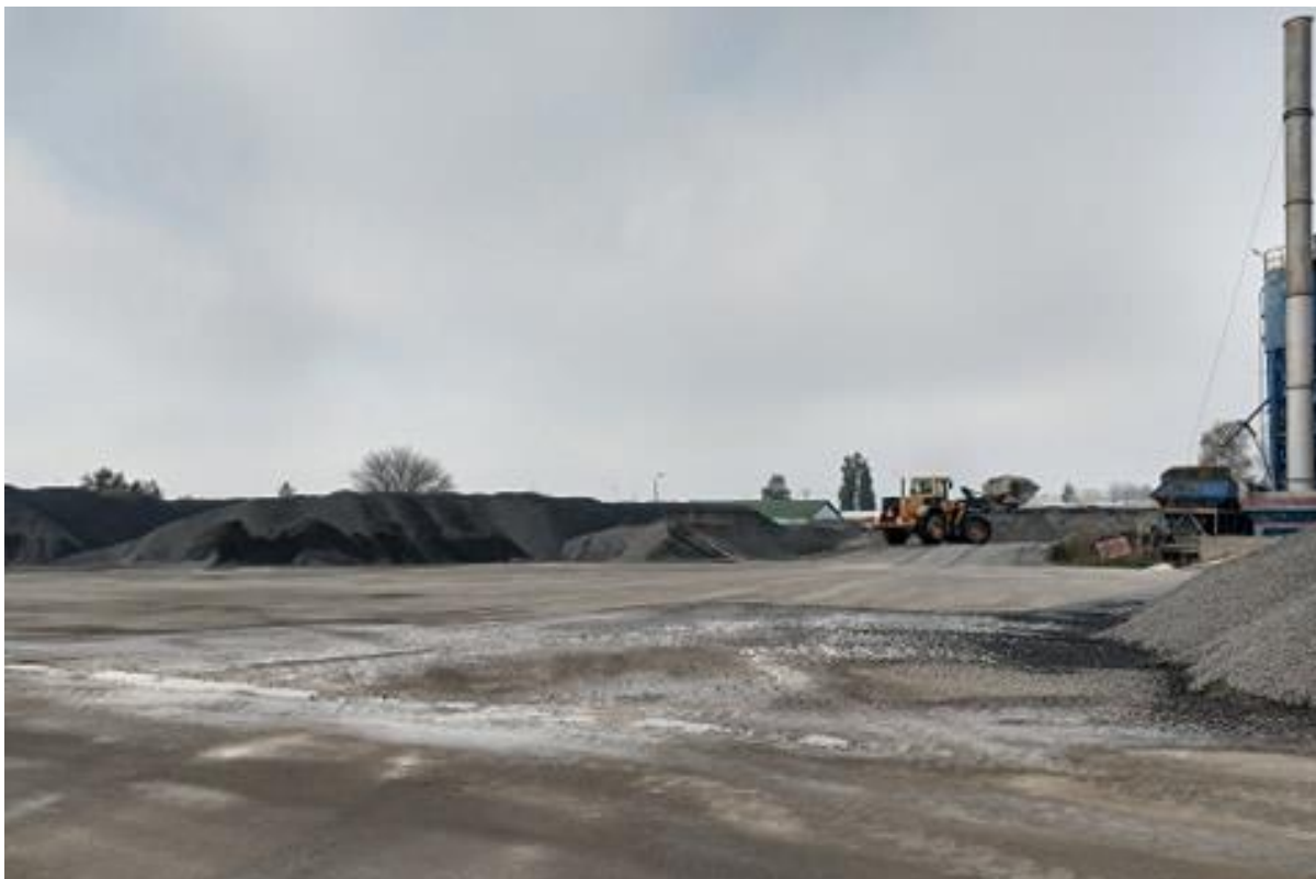
Po lewej stronie, teren magazynowy kruszyw, planowana powierzchnia magazynowa odpadów palnych, widok w kierunku południowo-zachodnim.
