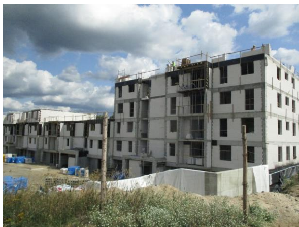
Piła – budowa budynku wielorodzinnego
