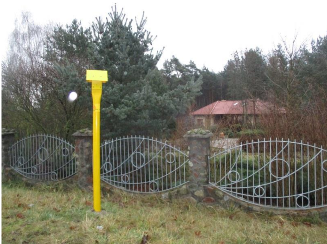
żółty słupek oznacza lokalizację gazociągu wysokiego ciśnienia
