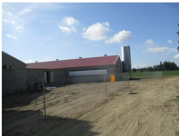
gmina Łobżenica – budowa budynków inwentarskich
