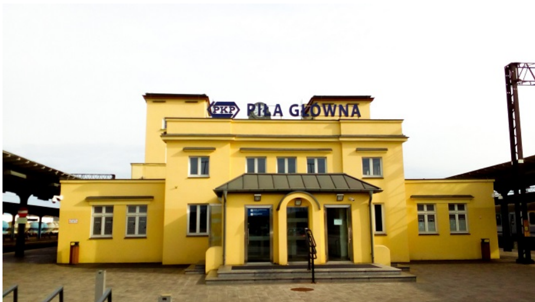
Główny budynek zabytkowego zespołu stacji kolejowej Piła Główna
