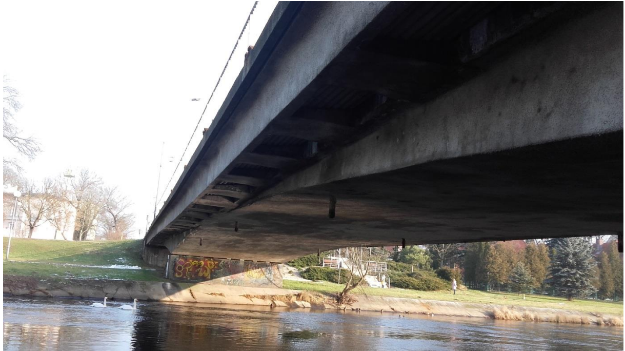
most im. Bolesława Krzywoustego w ciągu ul. 11 Listopada w Pile
