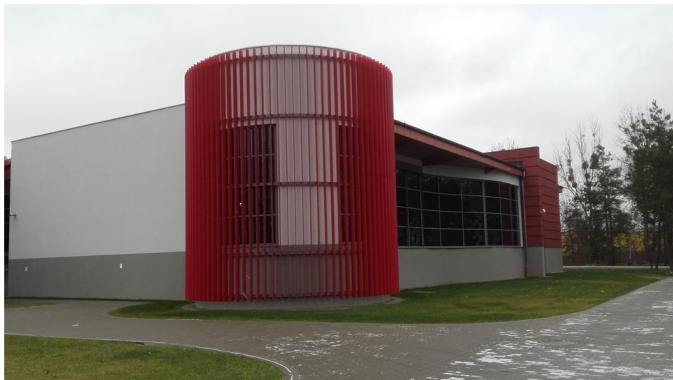
rozbudowa Centrum Sportowo-Rekreacyjnego „Aquapark” o basen sportowy Piła ul. Grottera
