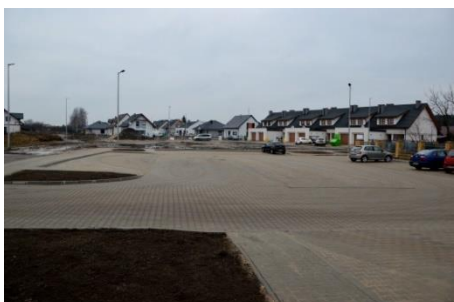
Foto: Budowa parkingu wraz z oświetleniem przy ul. Morelowej
