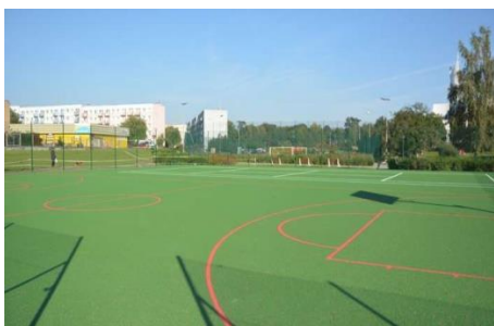
Foto: Przebudowa boiska wielofunkcyjnego przy ul. Złotej
