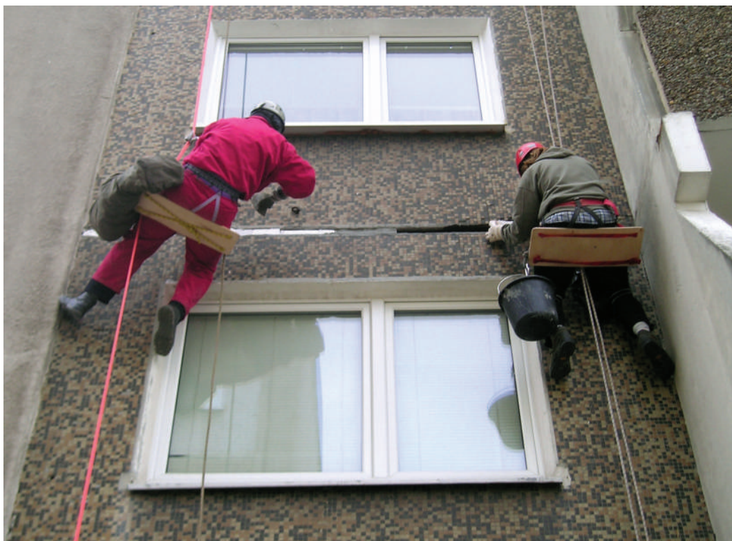
Fot. 10. Pracownicy wysokościowi podczas zabezpieczania szczelin na budynku (ABa)
