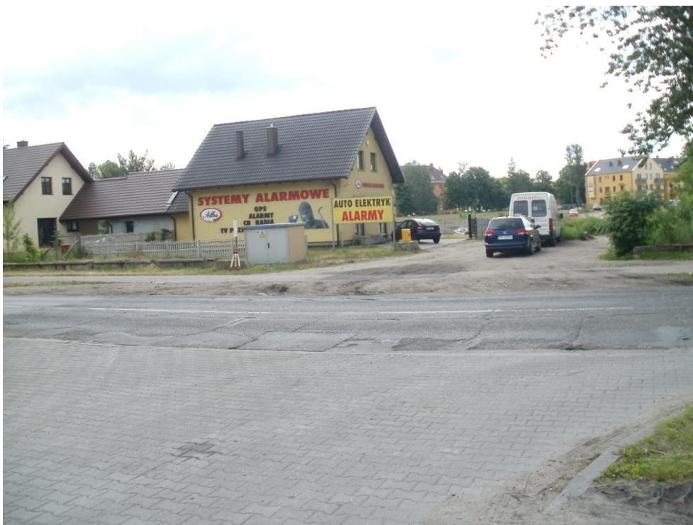
Fotografia NR 6 - ul. Kossaka – droga powiatowa
