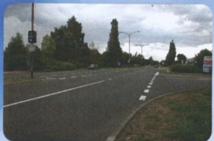
58 W miejscu bliskim skrzyżowaniu, z kierunku obwodnicy wystarczyłoby lewy pas „wyłączyć” oznakowaniem poziomym i pionowym tylko do skrętu w lewo (dla pojazdów nadjeżdżających od obwodnicy, drogi nr 10) – w kierunku ulicy Styki. Wówczas, gdy pojazdy jadące od drogi nr 10 w kierunku centrum poruszałyby się wyłącznie prawym pasem, wyjeżdżający z ulicy Styki w kierunku Centrum mieliby bardzo ułatwione zadanie.
