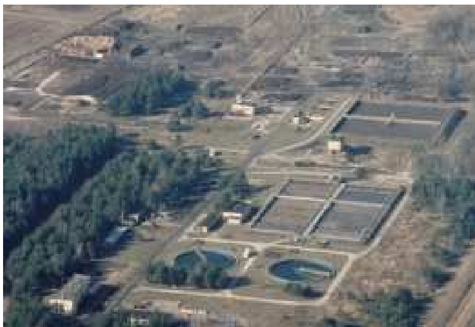
Fot. 8. Oczyszczalnia ścieków w Pile-Leszkowie.
